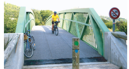
La passerelle dédiée aux piétons et aux cyclistes, une heureuse initiative
