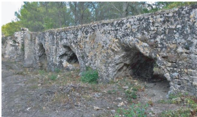
concrétions calcaires dues à des fuites et des prélèvements sauvages par piquages des agriculteurs au fil du temps
